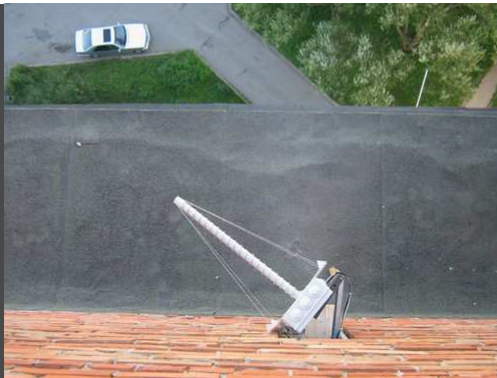
Установка Wi-Fi антенны на стене дома (точка доступа)
