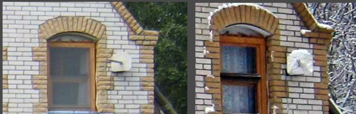
Установка Wi-Fi антенны на стене дома (клиентская часть)
